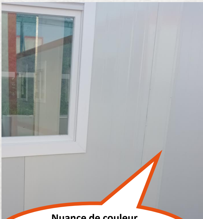
Nuance de couleur Entre cloisons (panneau neuf avec panneau jauni)
